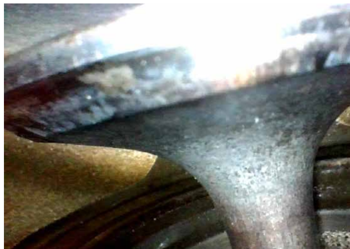
Foto superior: Inspección de la válvula
